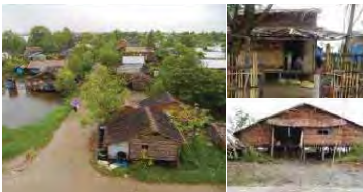
サイクロンナルギスにより壊滅したビレッジ（写真は復旧後）
