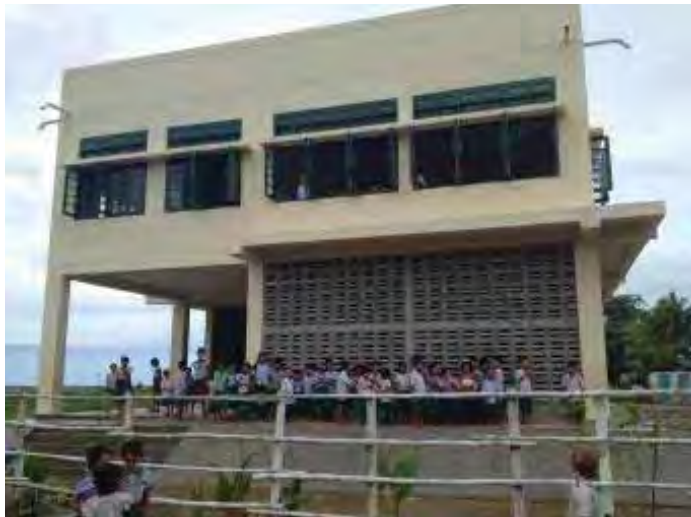
JICAの支援で作られた学校兼サイクロンシェルター
