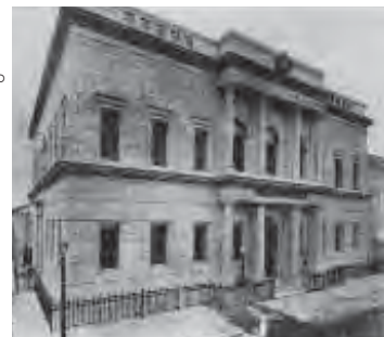
建築時の建物(三井銀行広島支店) 出典:「建築世界」(1925年7月)
