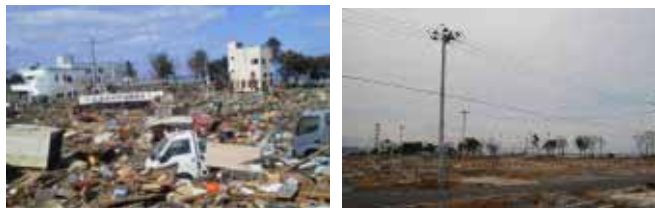
がれき撤去前と撤去後
