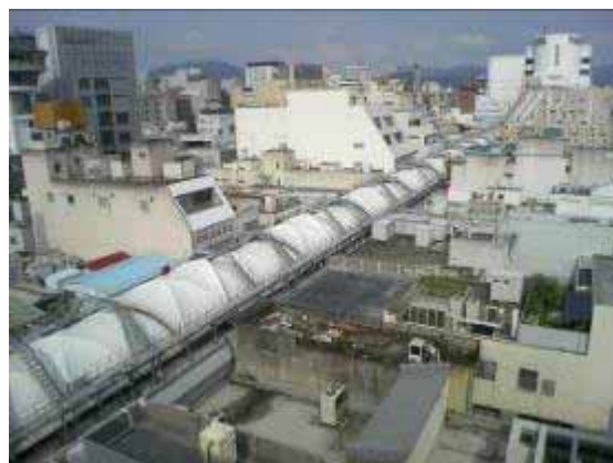
上から見た広島・本通商店街 (いつもと違う視点でみると楽しい。「屋上巡り」で本通アーケードの上のキャットウォークを歩いてみたい!)
