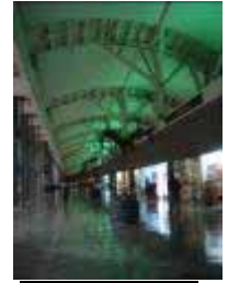
改装空港増築中。
