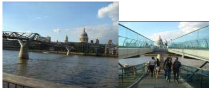
川だけに、橋も満載。これは2000年を記念して作られたミレニアムブリッジ。エリザベス女王が渡ったときに揺れたため、暫く通行禁止になったいわれ付き。しかし、骨でできたような現代技術と有機物のあいこのような雰囲気が良い。
