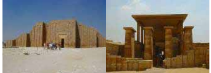
ジョセル王のピラミッド。初めて日干し煉瓦だけだった墓が増築で表面が石積みになった。ピラミッドコンプレックスで、周壁、神殿や列中の回廊がある。
