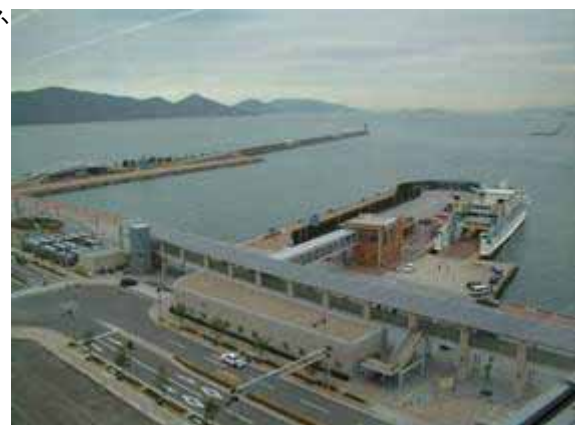
高松港、中央から右下方向に伸びるのは港と駅をつなぐペデ、屋根には太陽光発電のパネルが設置
